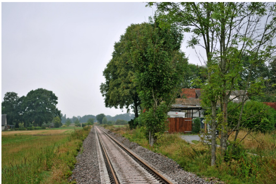
Fertiges Gleis der Zweigstrecke zum Hafen Dörenthe. Foto: J. Högemann
