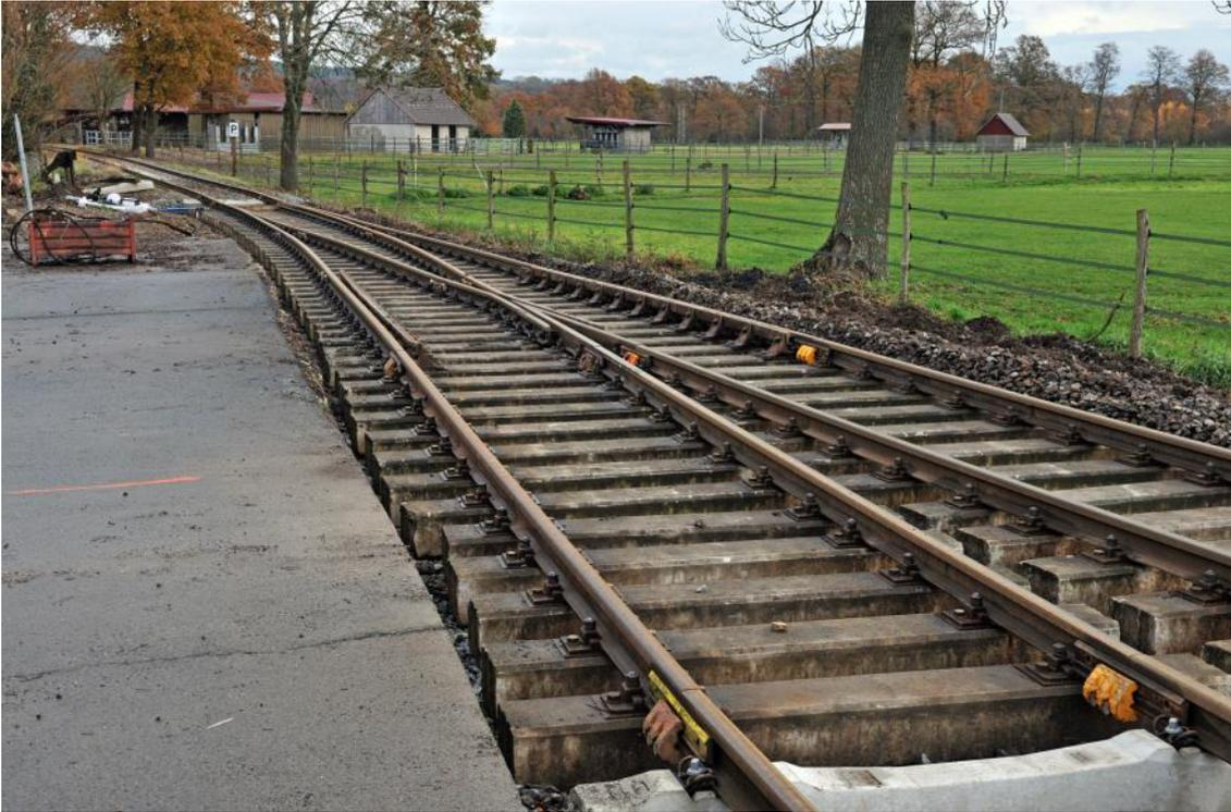
*Einbau einer gebrauchten aufgearbeiteten Weiche mit Betonschwellen in Dörenthe (27.11.19).
