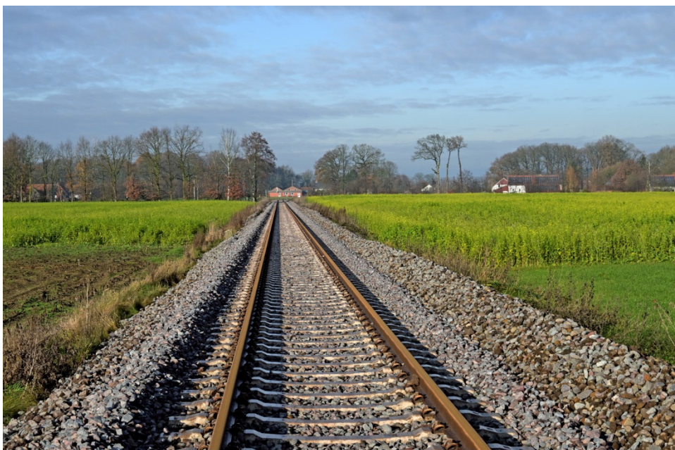
So soll es sein: Streckengleis nahe der Landesgrenze bei Müschen nach Abschluss der Arbeiten.
