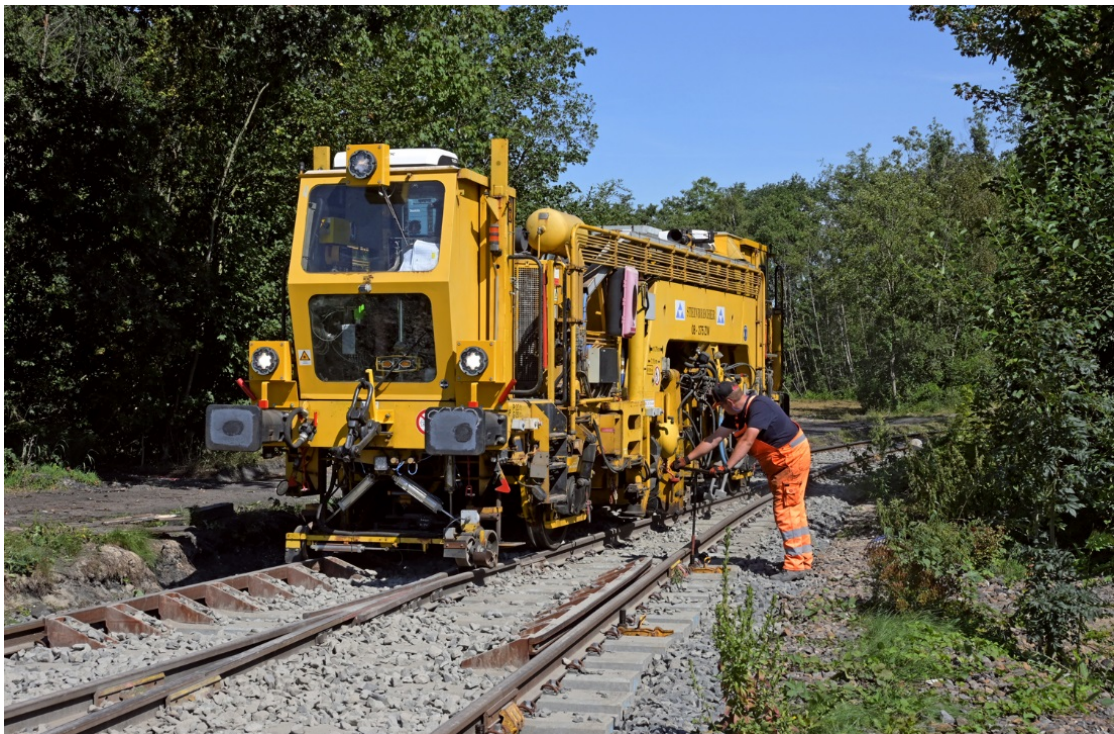
Eine spezielle Weichenstopfmaschine bringt den Oberbau im Weichenbereich in die präzise Lage.
