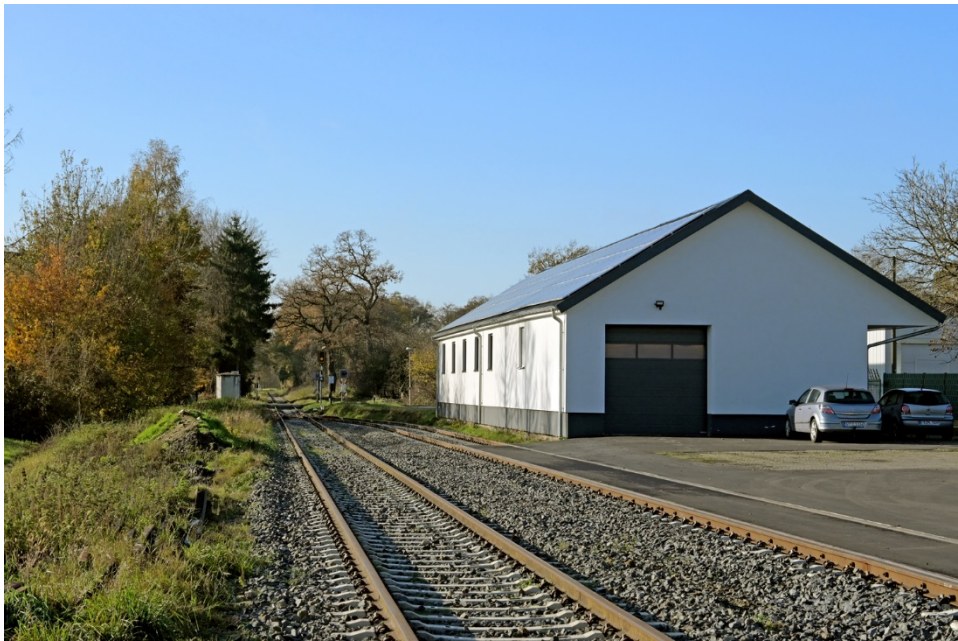
Der Bahnhof Ibbenbüren- Dörenthe mit ertüchtigtem Nebengleis und dem Büro- und Werkstattbereich der Lappwaldbahn Service GmbH
