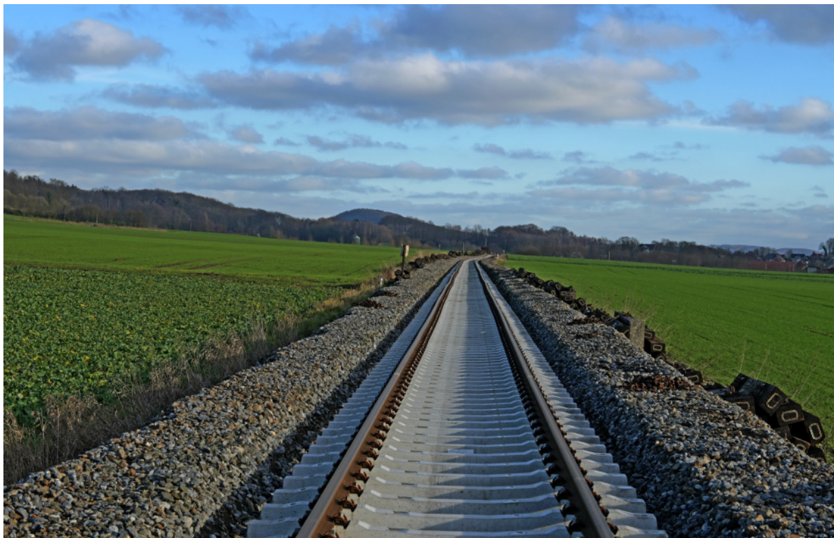
Ertüchtigung der TWE-Strecke zwischen Bad Iburg und Lienen an der Landesgrenze zwischen Niedersachsen und Nordrhein-Westfalen. Foto (10.12.2021): Josef Högemann
